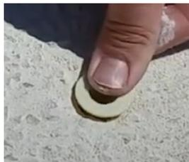
Fixation du module : insérer les 4 tiges inox dans les 4 fourreaux d'ancrage fixés dans le sol (le loquet de sécurité et la réglette avec vis doivent être côté piscine). La tige inox doit être complètement enfoncée dans le fourreau d'ancrage.
