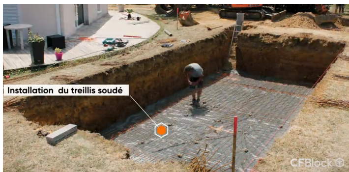
Armatures d'attente verticales pour solidariser les murs avec le radier
