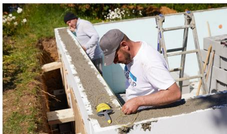
Afin de s'assurer du parfait remplissage des blocs procéder au débulage à l'aide d'une aiguille vibrante lors du remplissage. Lissez le béton en partie haute de manière parfaitement horizontale. Contrôlez l'aplomb des murs à l'aide d'un niveau et leur alignement à l'aide d'un cordeau. Corrigez immédiatement si nécessaire.
