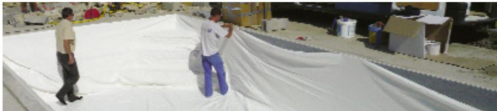
8. Centrer l'escalier et remonter la matière vers le haut. S'assurer que les soudures de liaison avec le mur correspondes aux angles et nez de marches. Les écarts doivent être identiques de part et d'autre de la même marche.
