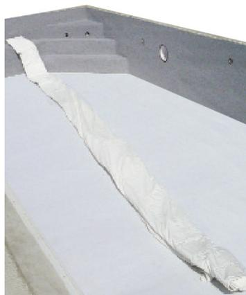
5. Repérer les angles des murs du liner identifiés par une flèche verte au dos du revêtement. Positionner la griffe d'accrochage fixée au liner dans les angles des profilés en haut des murs du bassin. Vous pouvez verrouiller le positionnement à l'aide d'un morceau d'une quinzaine de cm découpé dans la bobine de jonc de blocage. Repérer que les angles entre le fond et les murs soient bien positionnés.
