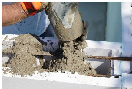
Coulage structure : remplir à la pompe à béton en déversant ce dernier sur l'entretoise (et non directement dans la chambre) par hauteur maximale de deux à la fois.
