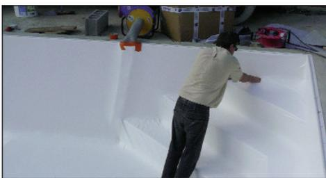
Décrocher le liner dans le petit bain pour enfiler le tuyau de l'aspirateur ou du Qvac à environ 15 cm du fond.
