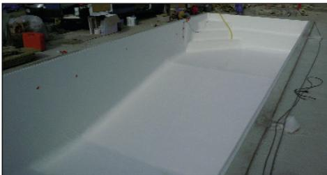
Le liner doit être tendu de façon égale sans surtension. Aucun pli ne doit subsister dans le fond avant la mise en eau.
