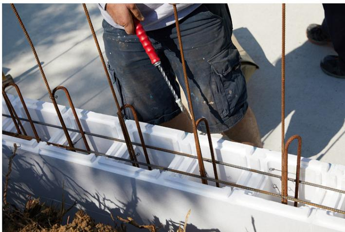
1. Enterré : fer à béton côté remblais
