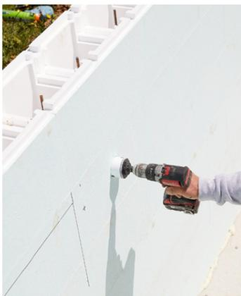
Pièces à sceller : découpez le polystyrène à l'aide d'une scie queue de rat ou d'un styrocutter, voire d'une scie cloche pour les pièces circulaires, puis insérez chaque élément en ajustant à fleur des blocs et en éliminant si nécessaire les armatures gênantes.
