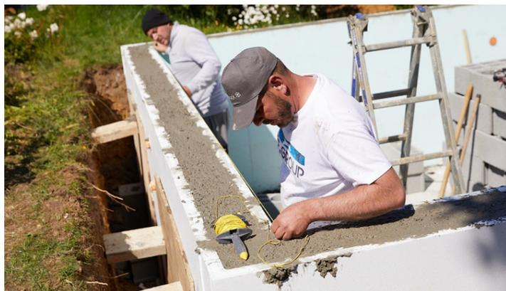
Lissage du béton d'arase : une fois le remplissage terminé, lissez le béton en partie haute de manière parfaitement horizontale. Contrôlez l'aplomb des murs à l'aide d'un niveau et leur alignement à l'aide d'un cordeau. Corrigez si nécessaire.
