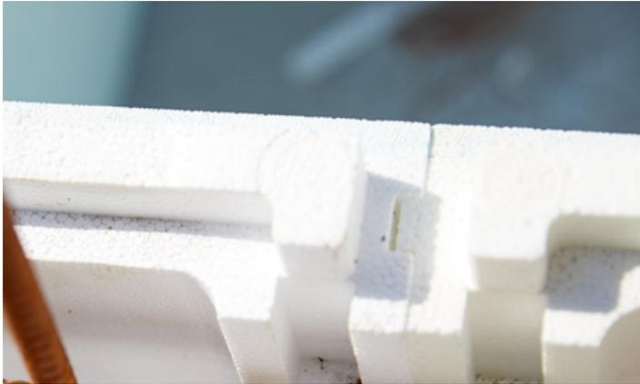
Engagez les blocs polystyrène au-dessus des armatures métalliques puis descendez les jusqu'au sol. Ils se placent les uns à côté des autres en emboîtant la partie mâle avec la partie femelle, pour réaliser la longueur et la largeur de la piscine.
