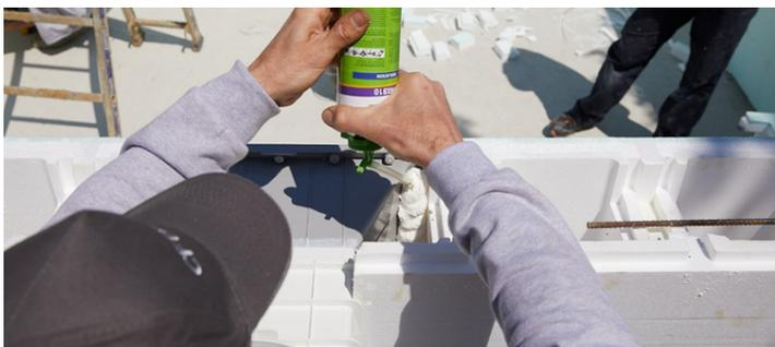
Étalez les blocs au moyen d'étais, de planches ou bastinges préalablement au coulage.
