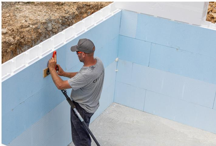
Montage structure : les rangs suivants ne nécessitent pas de mousse polyuréthane et s'empilent par emboîtement.
