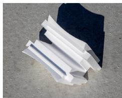
À chaque angle, découpez au styro-cutter, ou à la scie, la face intérieure des blocs polystyrène, au dessus et en dessous, pour permettre la liaison horizontale du béton et des fers à béton.
