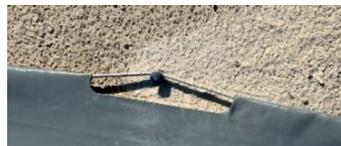
*Il est indispensable que la corde ne soit pas rectiligne lorsqu'elle sera positionnée derrière la tête de l'ancrage.*
