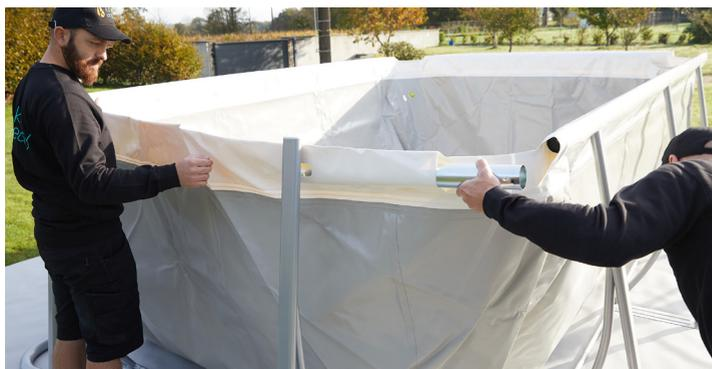
Renouvelez l'opération sur les quatre côtés du bassin tout en faisant attention à ne pas disposer les tubes de 60 cm (C) face à face.
